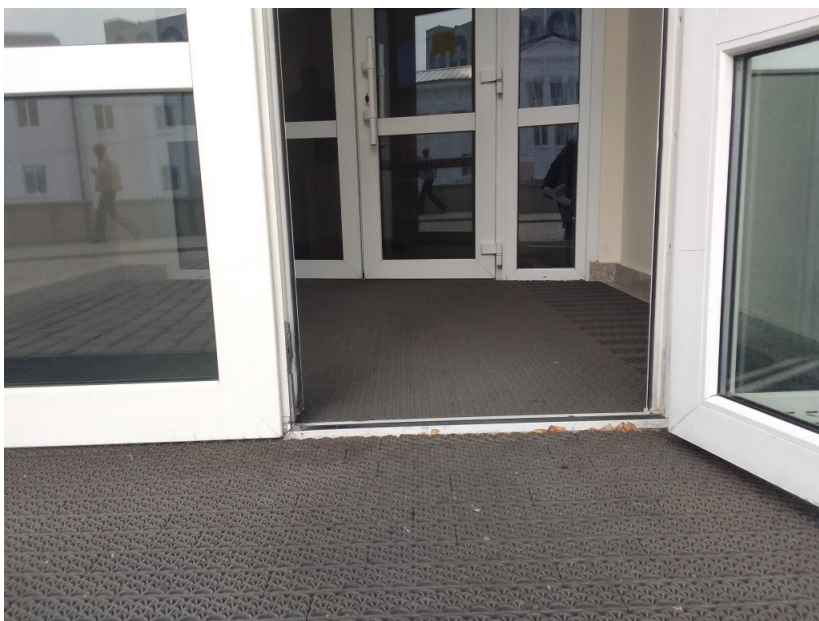
Фото 2.5 Порог входной двери
