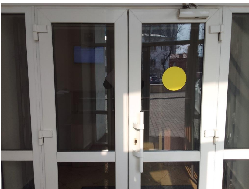
Фото 2.8 Дверь из тамбура в холл
