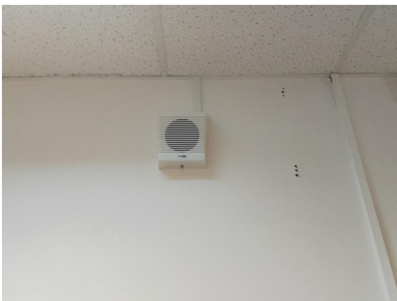
Фото 6.13 Звуковой оповещатель
