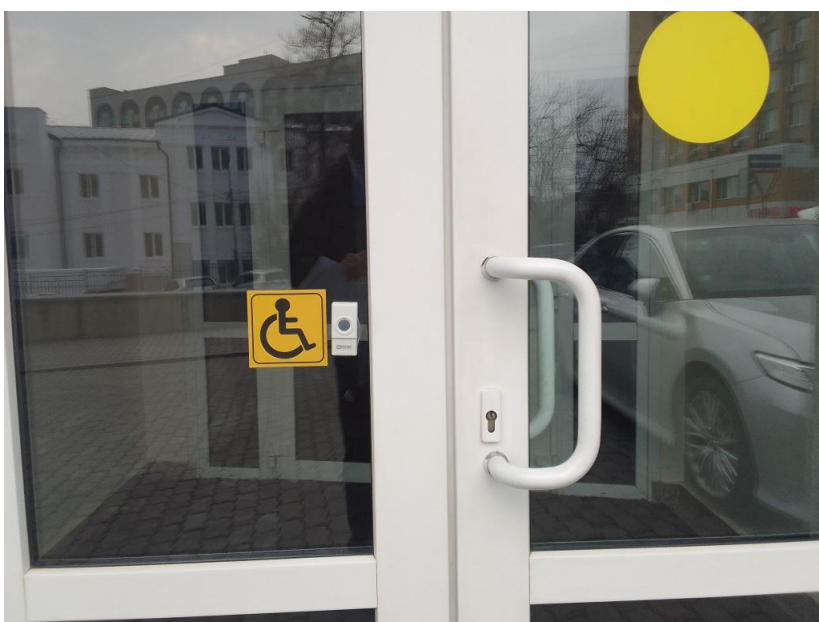
Фото 2.3 Наружное вызывное устройство
