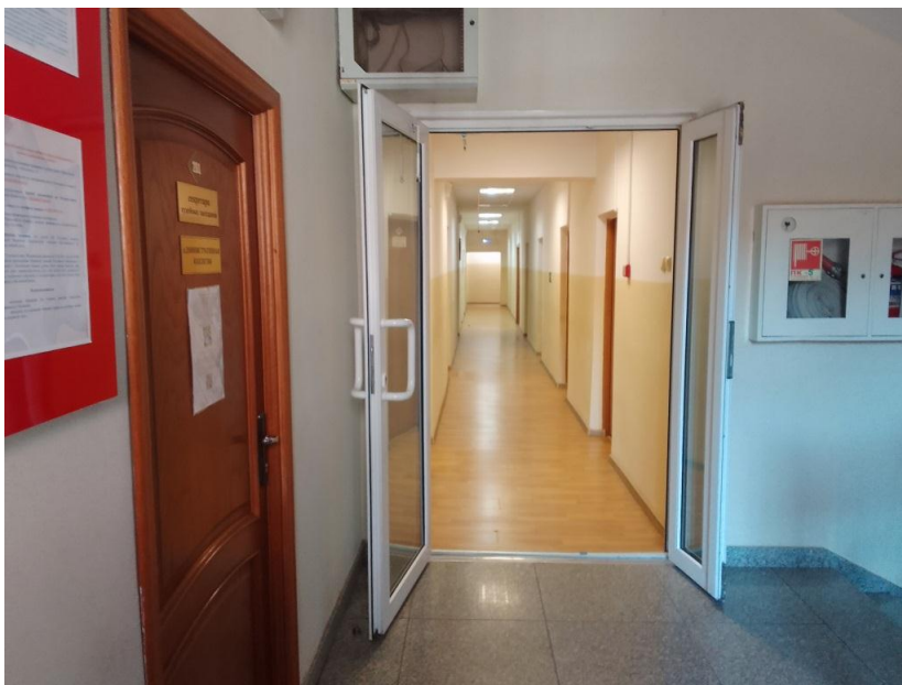
Фото 3.21 Дверь в коридор 2-го этажа
