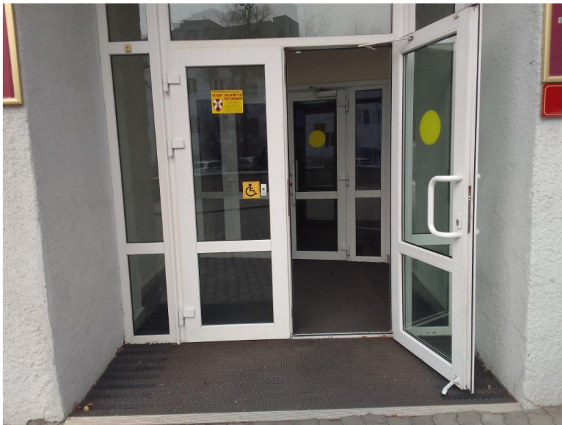
Фото 2.4 Проем входной двери
