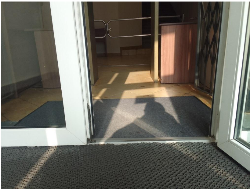
Фото 2.10 Порог двери из тамбура в холл
