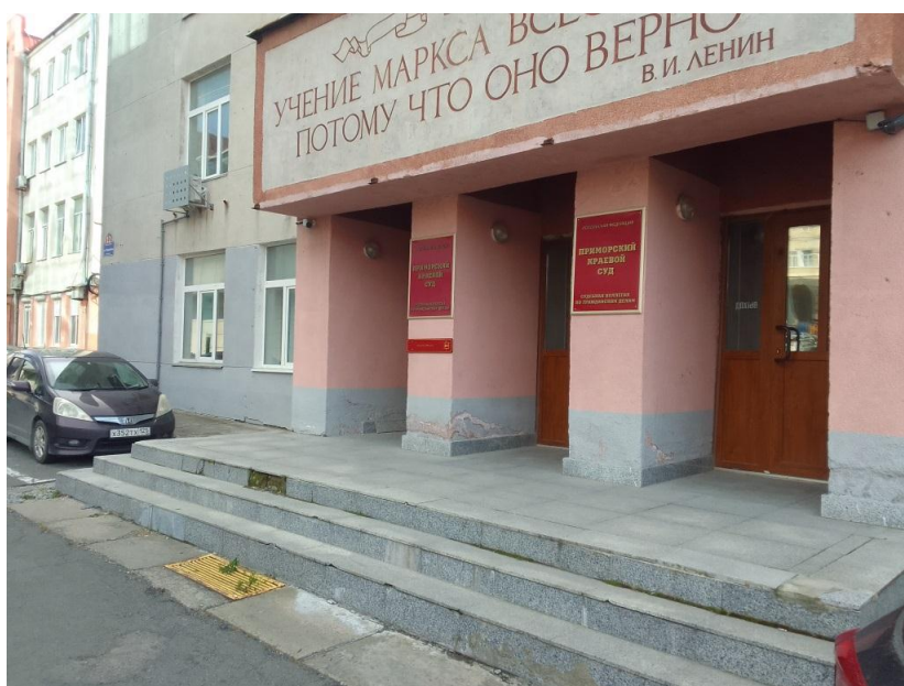
Фото 2.2 Лестница перед входной площадкой
