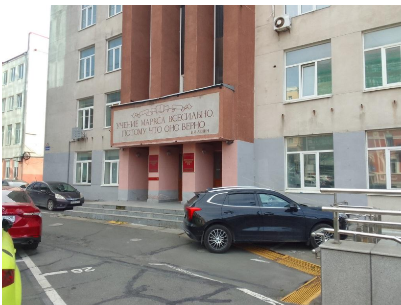
Фото 1.5 Территория перед зданием
