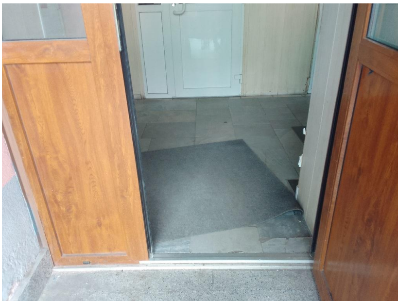
Фото 2.4 Проем входной двери
