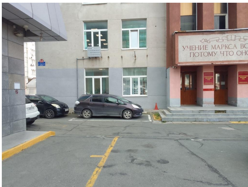
Фото 1.2 Территория перед зданием
