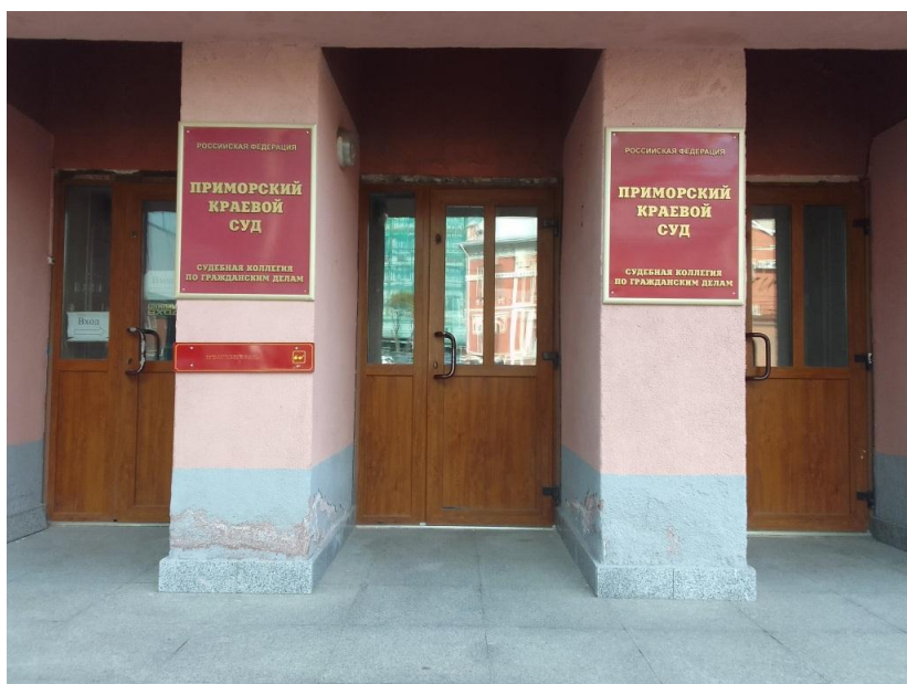
Фото 2.3 Входная площадка и входная дверь
