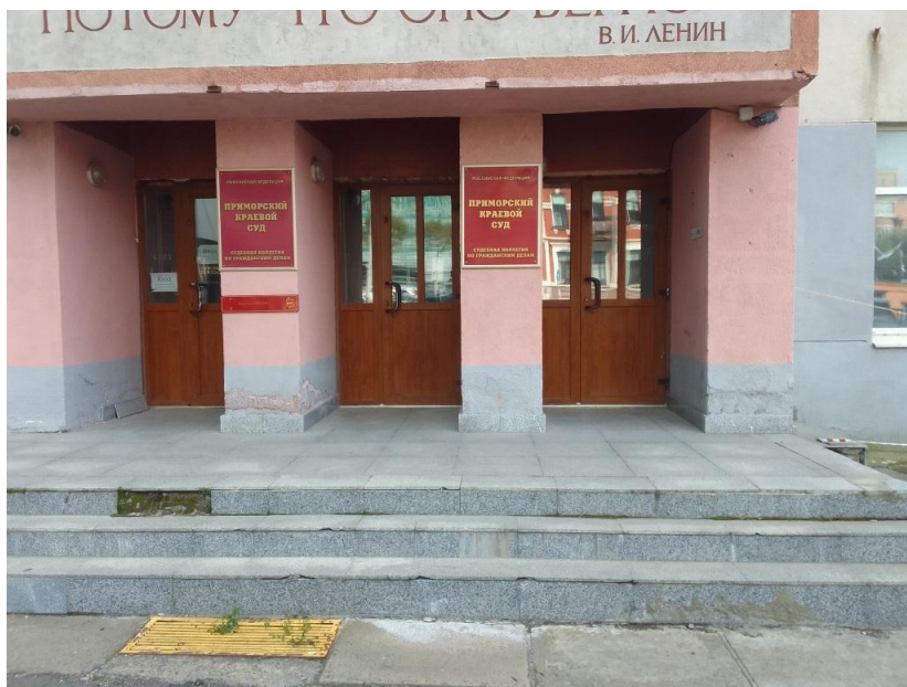
Фото 2.1 Лестница перед входной площадкой
