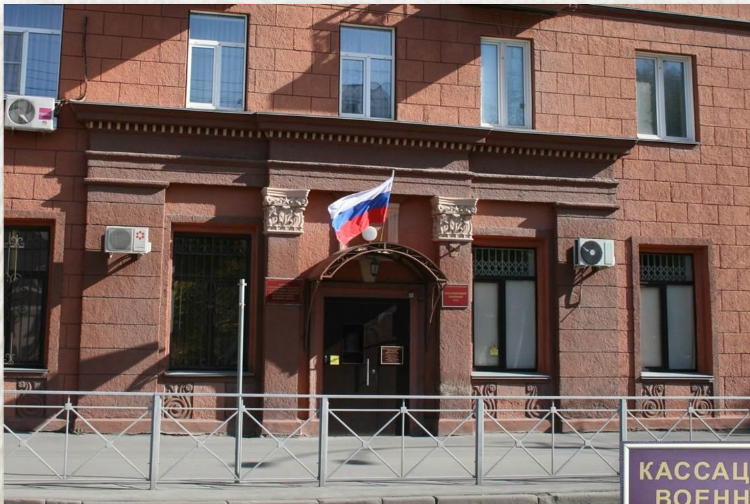
Здание кассационного военного суда, г. Новосибирск Красный проспект, д. 64
