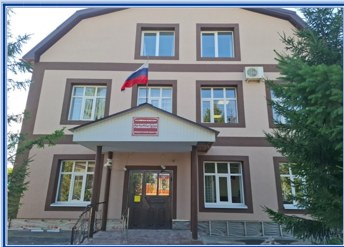
Фасад здания Саракташского районного суда после ремонта
