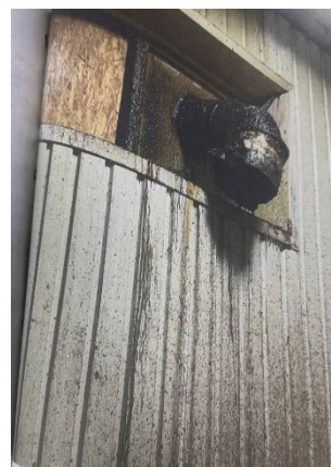
п. 4, п. 9 стена производственного помещения
