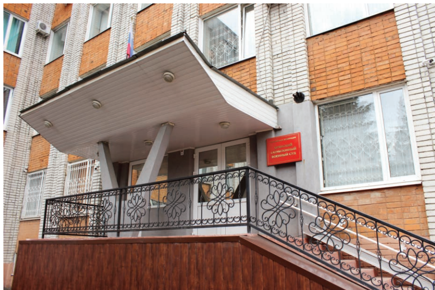
Здание Брянского гарнизонного военного суда
